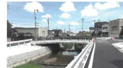
完成した中根橋と護岸
