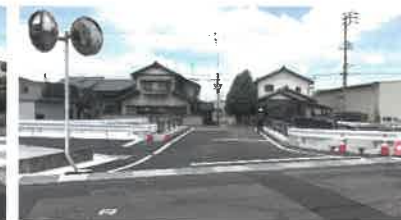
東側から見た中根橋
